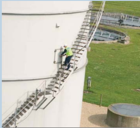
Réservoir de stockage d'Anglian Water AWG Plc (1,1 milliard $)
